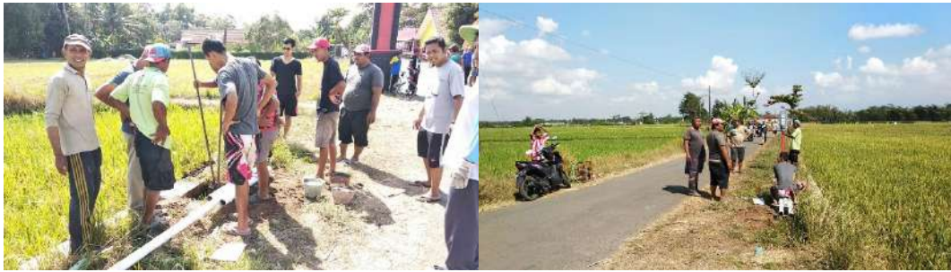
Gambar 8 Suasana Pemasangan Tiang dan Lampu Penerangan Jalan
