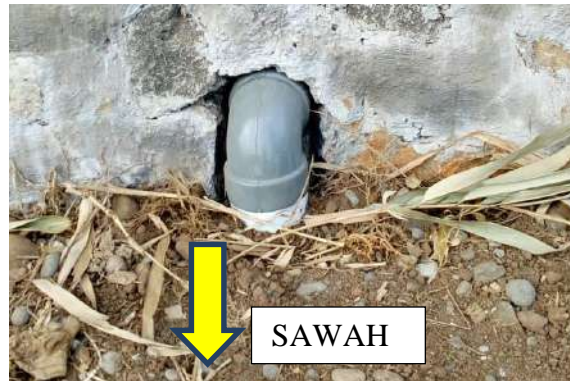
Gambar 5. Pralon dari kolam ke sawah yang sudah dipasang
