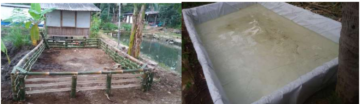
a. Kerangka kolam dan pemasangan terpal
